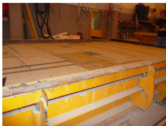
Рисунок 23. Бетонное покрытие диагональных связей во внутреннем слое.
