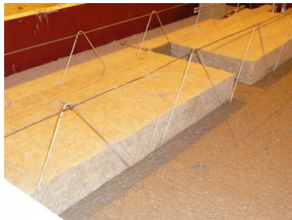
Рисунок 21. Заполнение стыков между жесткой теплоизоляцией.
